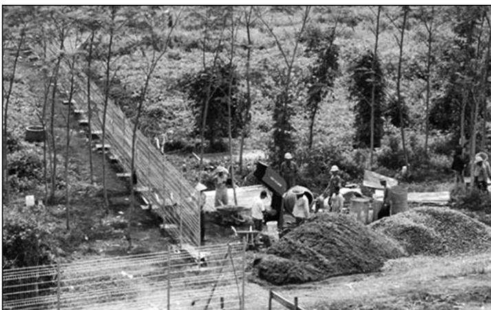
Pemagaran lokasi runway NYIA dibidang lahan yang diklaim sebagai Pakualamanan Ground (PAG) di Desa Jangkaran sepanjang 5000 meter. Sebelumnya telah dilakukan pemagaran di perbatasan Desa Kebonrejo dan Desa Palihan. (30/1/2017)
